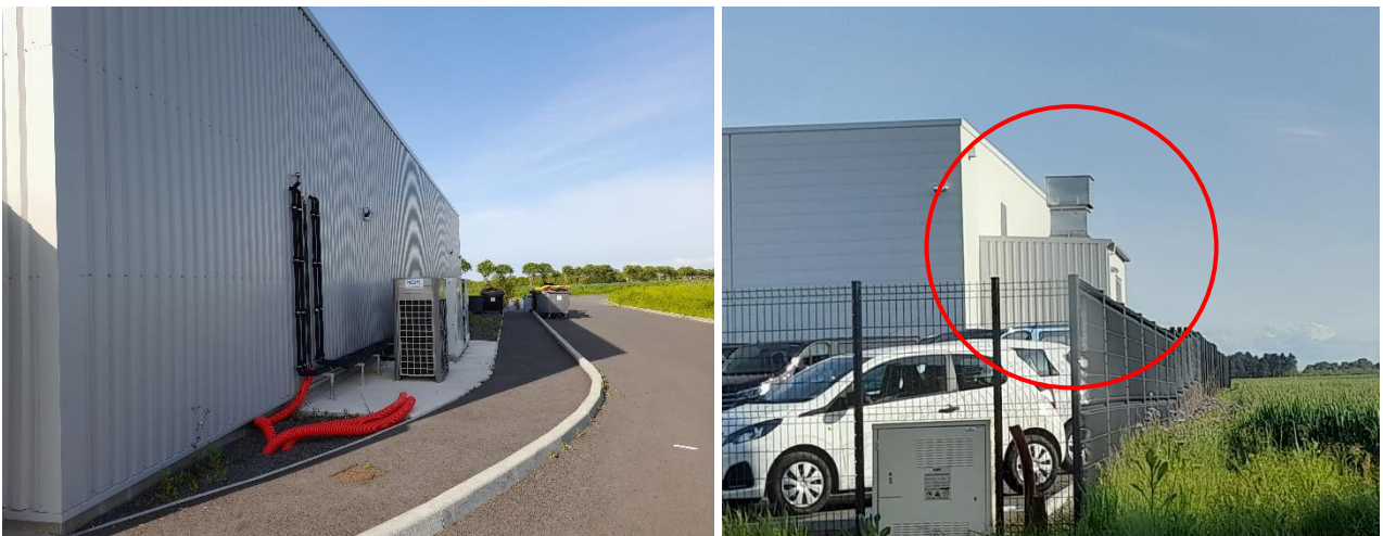
Figure 3 : Groupes froids du centre commercial (à gauche) et extracteur d'une cabine de peinture du concessionnaire automobile (à droite)
