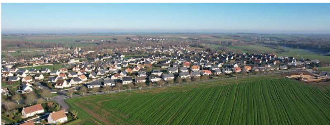
Vue haute de la zone d'étude (source : PA2 – Atelier PAGE)
