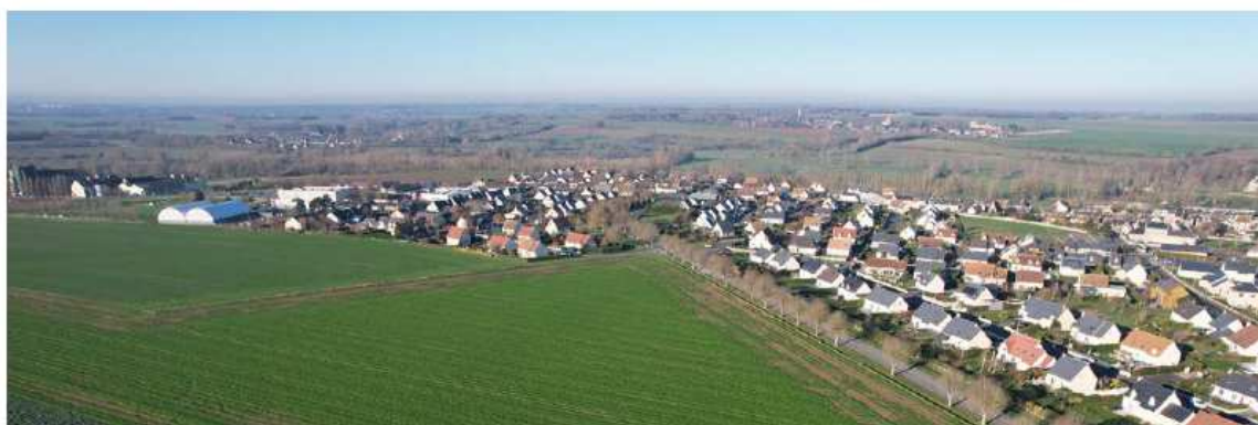
-6- Vue haute depuis les limites Sud-Est vers le Nord-Ouest.
