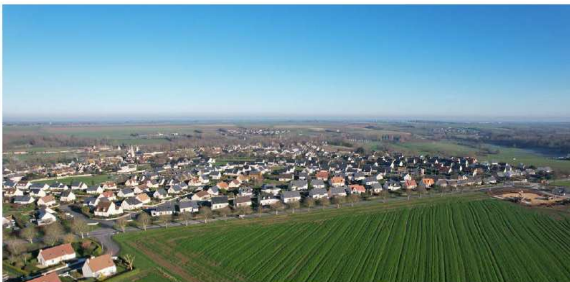
-5- Vue haute depuis la limite Sud du projet vers le Nord.
