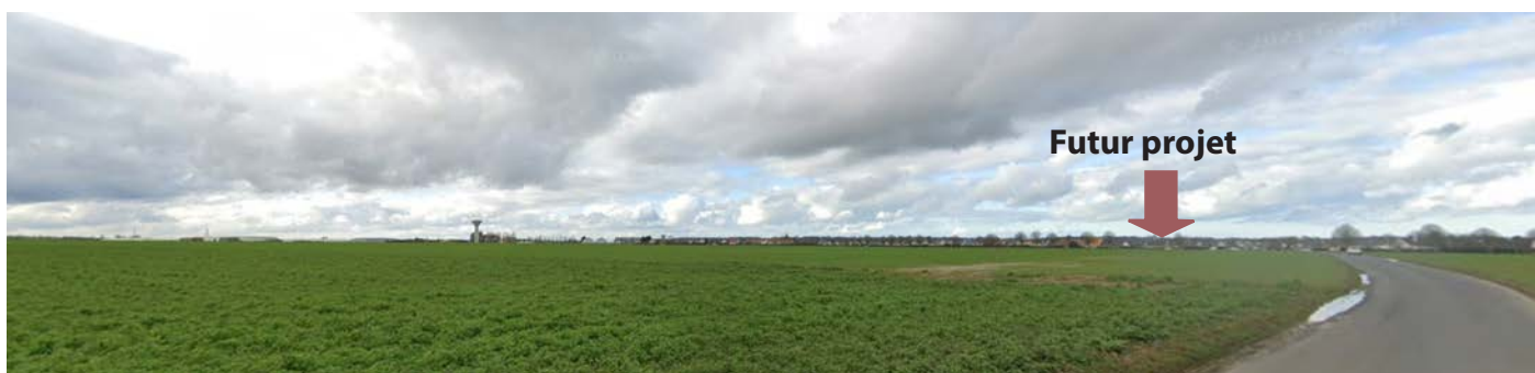
-6- Vue lointaine depuis la D93 (route de Lantheuil) vers le Nord.
